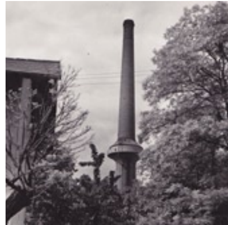
Schornstein des Dampfkraftwerks
